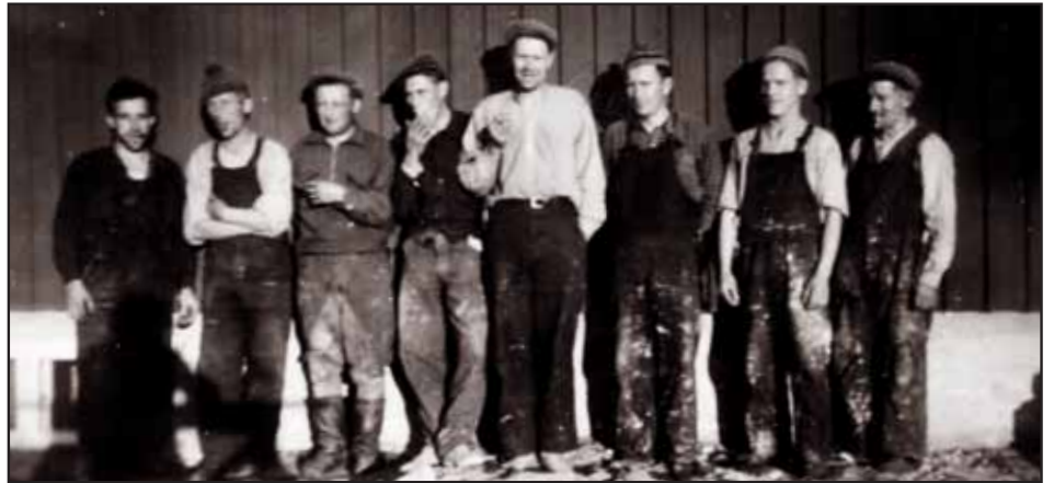
Koulun rakentaminen houkutti ammattimiehiä, joista osa jäi pysyvästi paikkakunnalle. Rakentajat vasemmalta: Einari Heikkilä, Pentti Heikkilä, Vilho Kähtävä, Joonas Pirttijärvi, Jutilan Arvo, sekä "Pikku-Pentti", joka tässä vaiheessa jäi tarkemmin tunnistamatta. Rakentajat tulivat Alavieskan Kähtävän kylästä. Kuva: Joonas Pirttijärven arkisto
