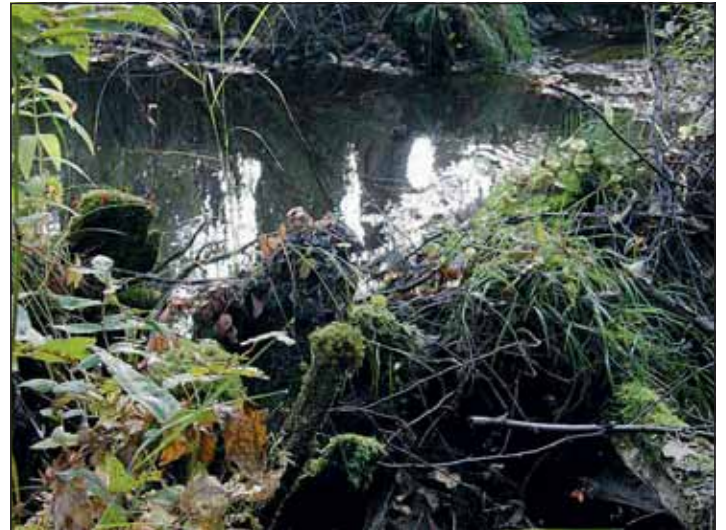
Kosken niskalla on vielä nähtävissä joen patorakenteita
