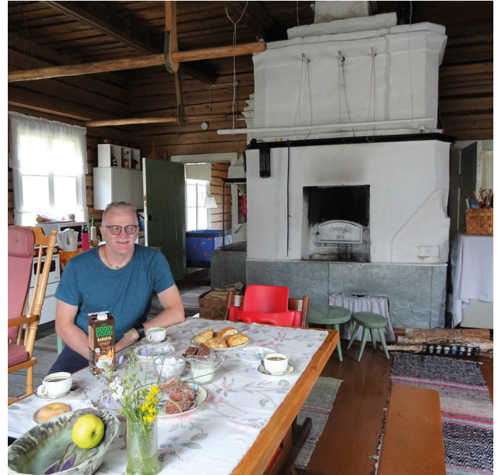
Leivinuuni kamareiden puoleisella päätyseinällä. Uunin molemmin puolin käynti kamariin. Uunin toisella puolella hella ja keittiönurkkaus. Samanlainen pohjaratkaisu oli Myös Kotiniemen ja Mursunahon taloissa. Pitkänpalon pirtti on alkuperäisessä asussa. Pirtin kesäpäivän rauhassa vanhan, komean leivinuunin edustalla tekniikan tohtori Raimo Antinpoika Ihme, Pitkänpalon nykyinen omistaja. Kuva T.I
